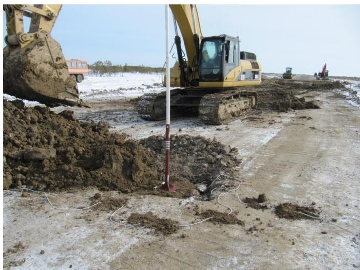
Рис. 2- Установка марок для контроля деформаций
